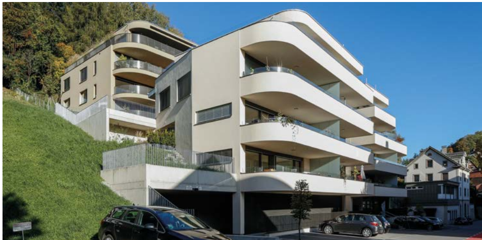
WA Liechtensteiner Straße Feldkirch
